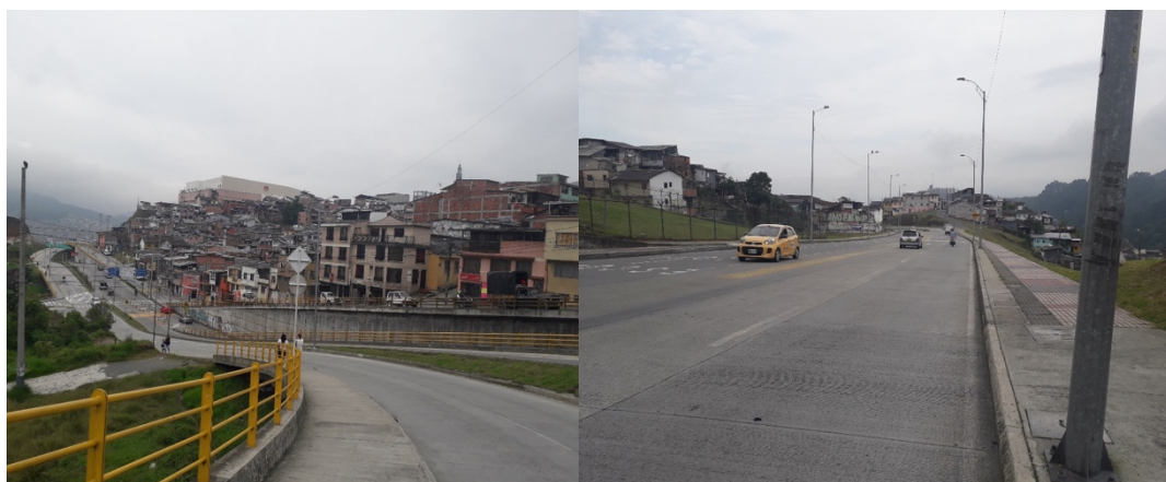
Figura 2 Avenida Marcelino Palacios
